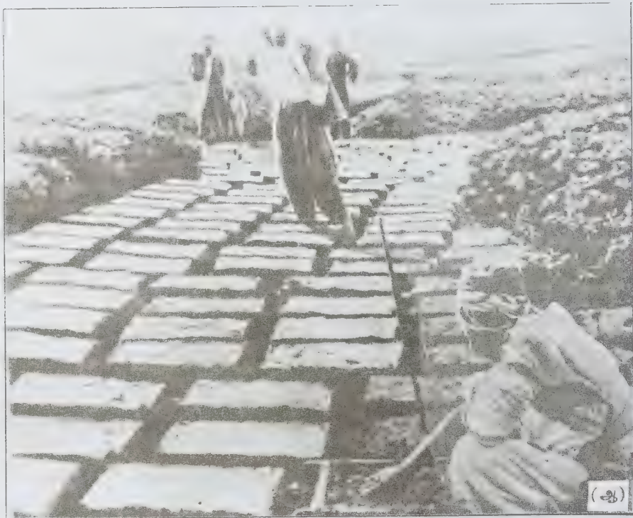
படம் 3 (அ) (ஆ) களிமண் மரவார்ப்புகளில் இடப்பட்டுச் சூரிய ஒளியில் காய வைக்கப்படுகிறது
