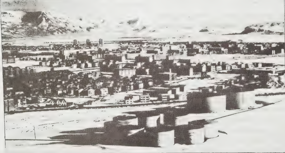
படம் 11. ரைக்ஜாவிக்க் புவி வெப்பமூட்டும் அமைப்பிற்கு உதவும் வெப்ப நீர்த் தேக்கங்கள்
