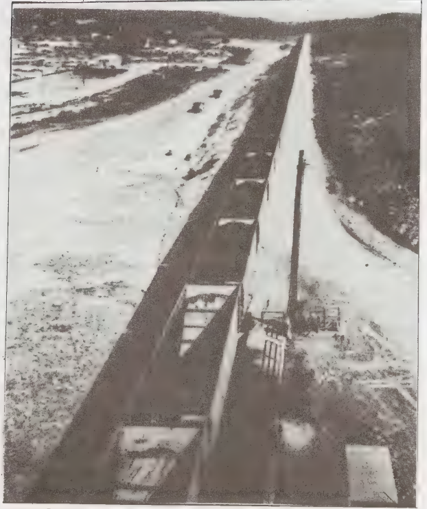
படம் 16 டென்னசியில், புல்ரன் (Bull Run) என்ற இடத்தில் டென்னசி பள்ளத்தாக்கு அதிகாரக் குழுவினரது நீராவி நிலையத்தில் ஒரு தொடர் வண்டியானது துள்ளும் வண்டிகளைக் (hopper cars) கொண்டு வேகச் சுமையிறக்கம் செய்வதைக் காணலாம்.
